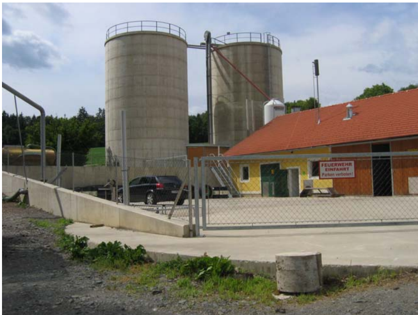
Abbildung 7.2: Lagerbehälter für Körnermais und Deckel von Hauptfermenter 1.
