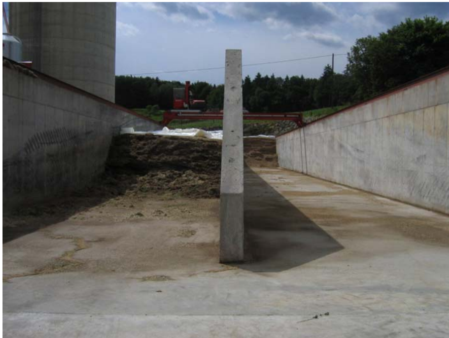
Abbildung 7.5: Fahrsilos für die Mais- und Grassilage
