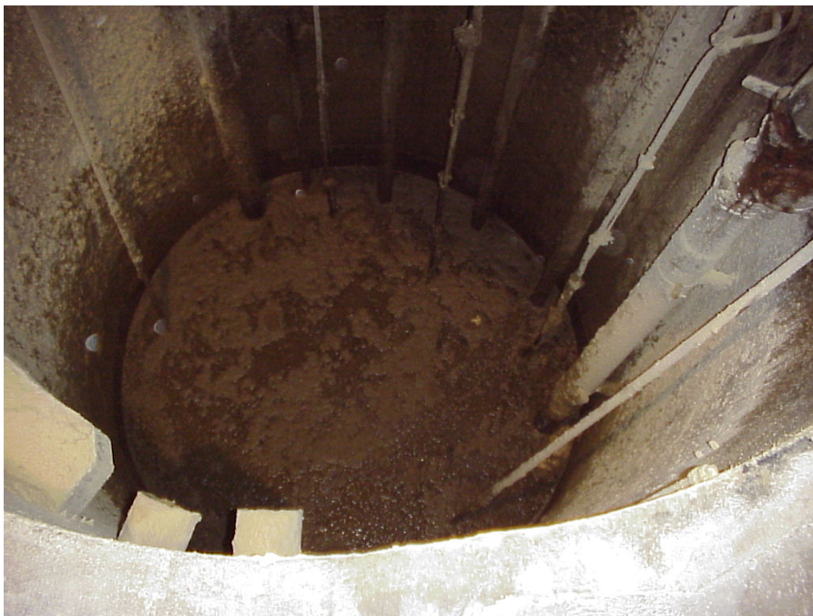
Abbildung 7.4: Blick in die Vorgrube der Biogasanlage Paldau
