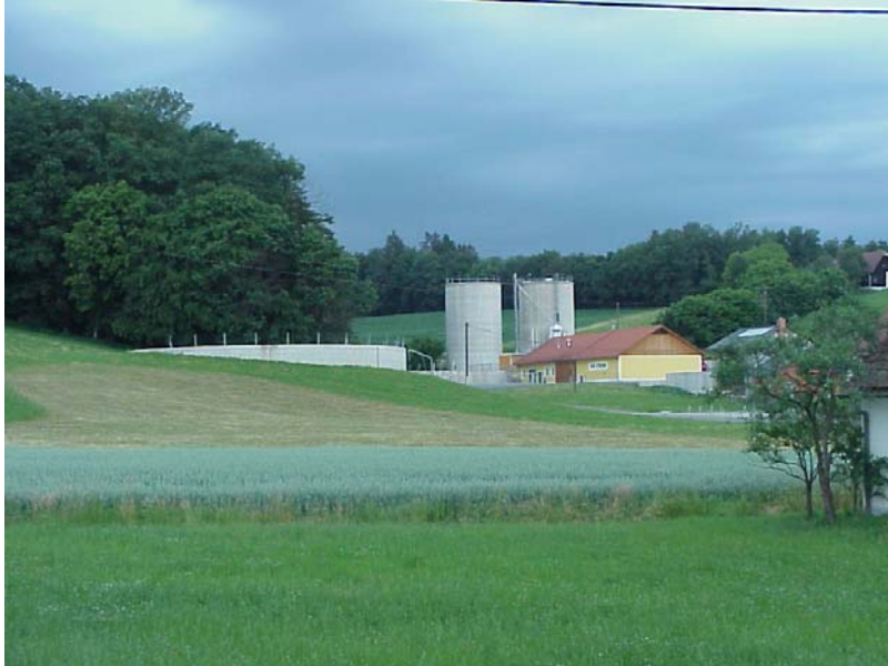
Abbildung 7.1: Foto der Biogasanlage Paldau
